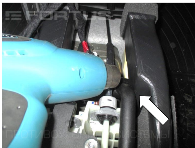
24. Деформируйте патрубок воздуховода по форме замка, подогрев патрубок с помощью фена
