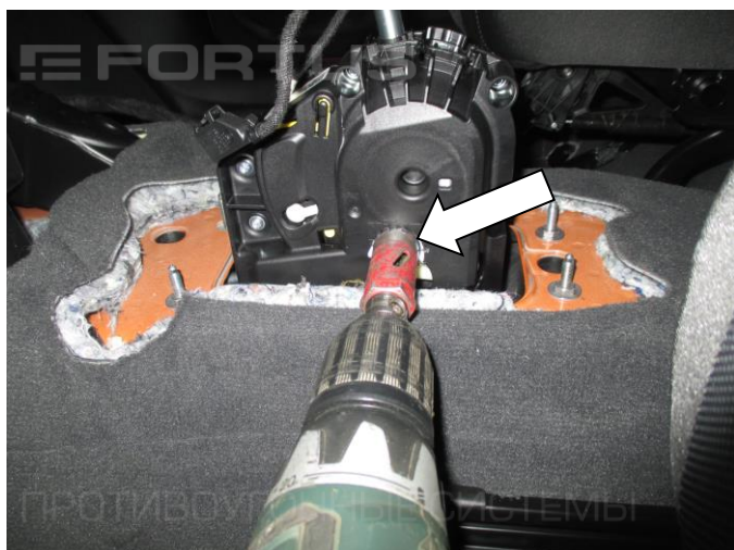
25. Просверлите отверстие в стенке селектора фрезой \varnothing 22 мм
