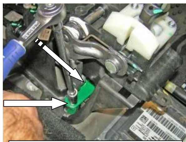
Установить защиту ригеля на столбики, закрутить срывной болт
